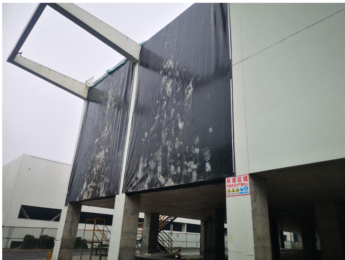
一期项目物料吊装区域
