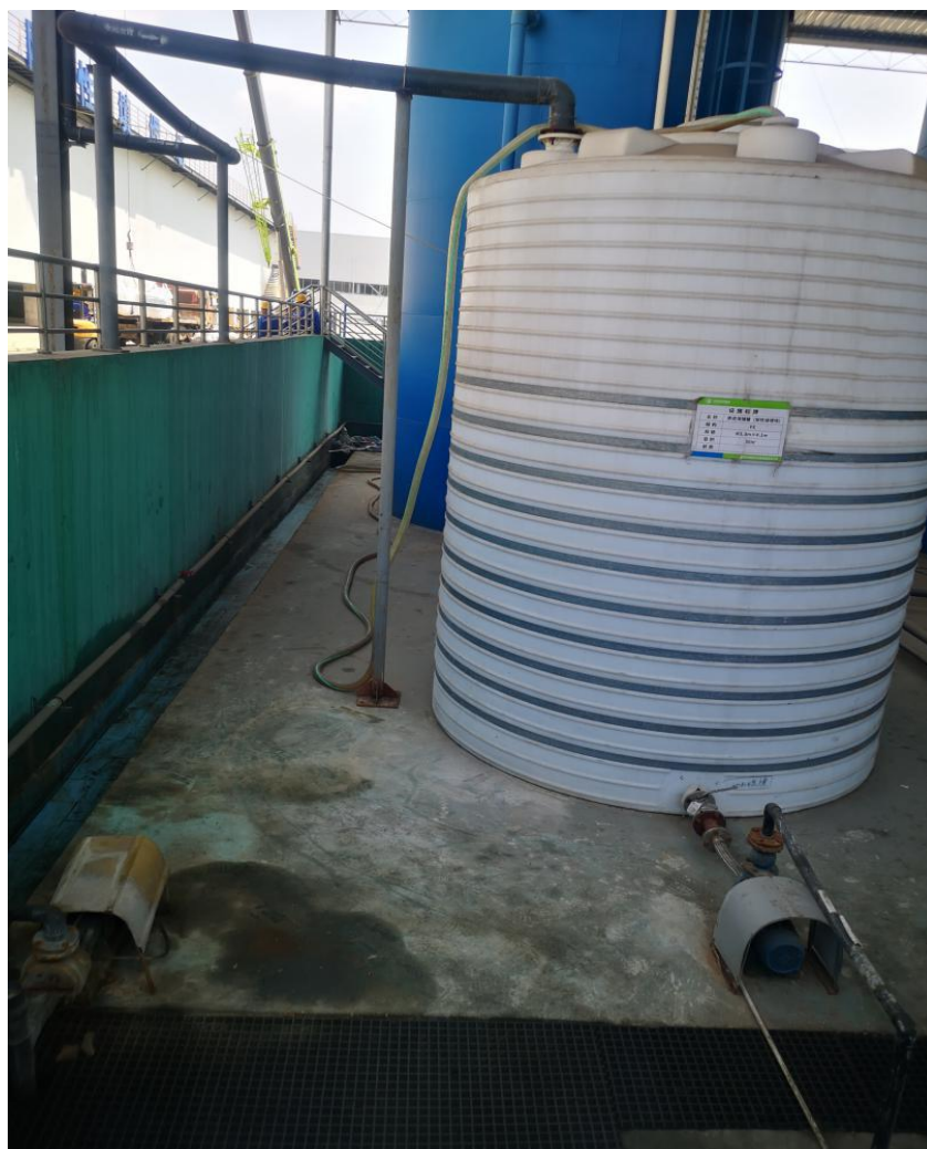
废水储罐区收集沟
