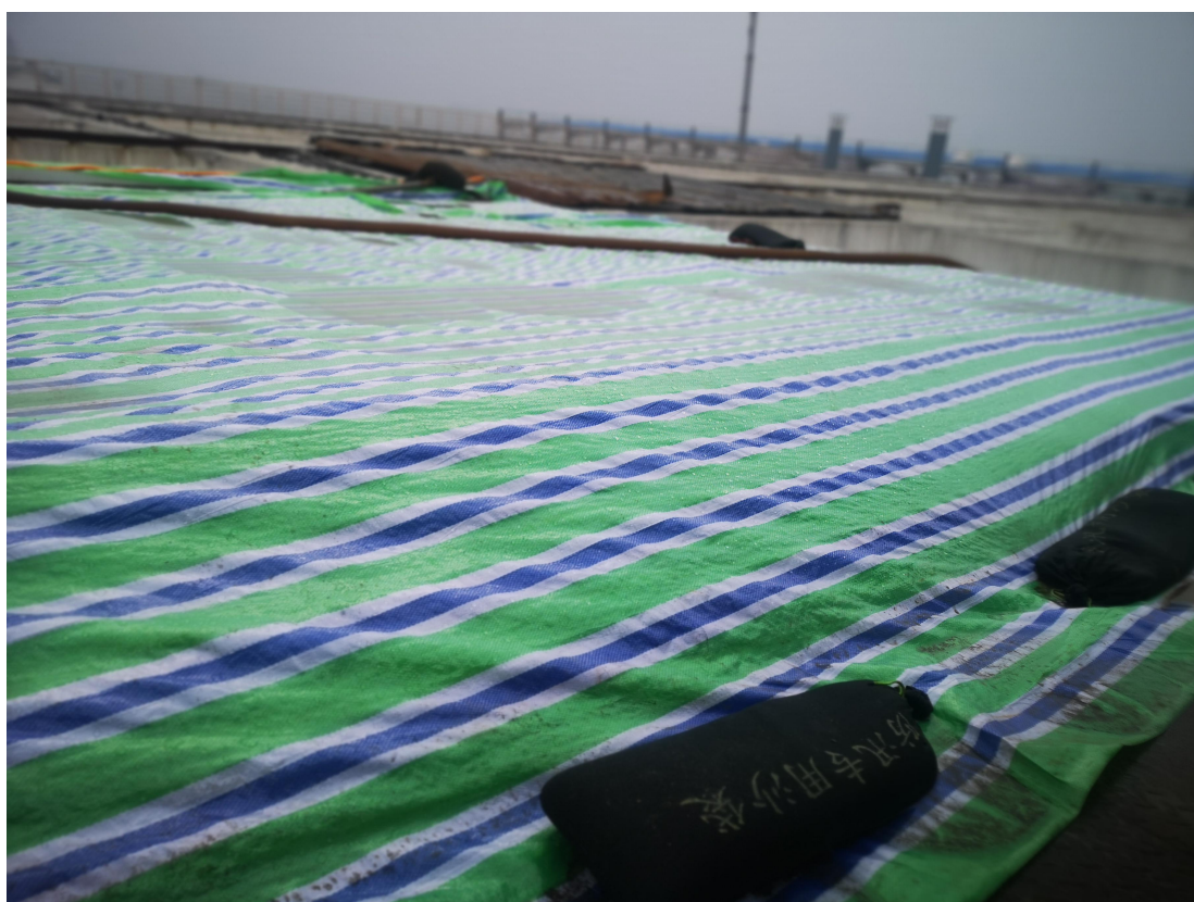
一期项目填埋区（填埋阶段不作业时段上面覆盖防雨布）
