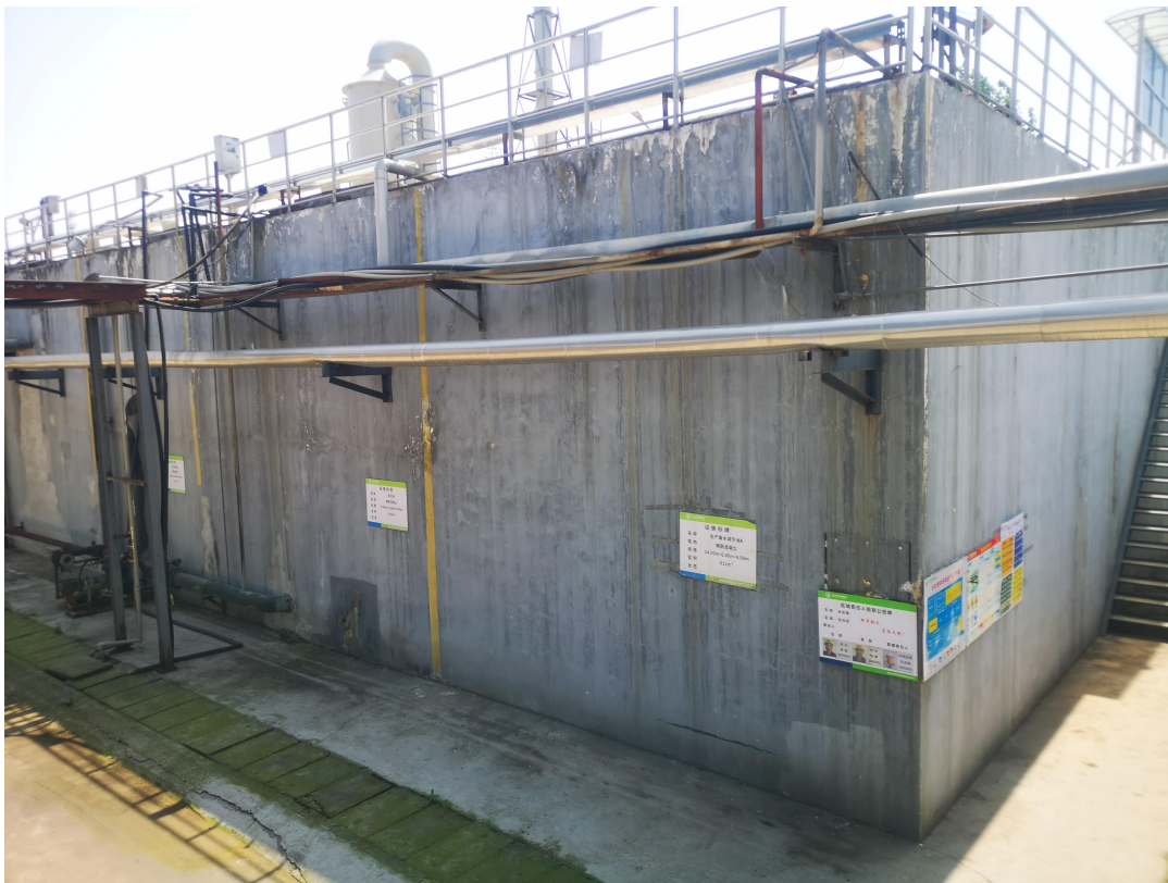
综合污水处理站（非禁排类）
