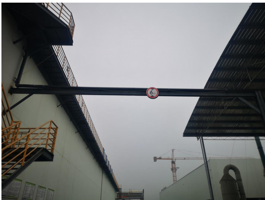
刚性填埋场渗滤液收集管
