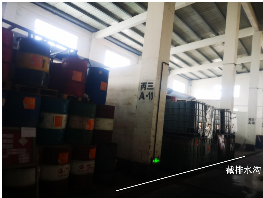
丙三仓库截排水沟
